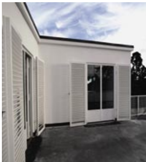
Til venstre: Husets vestfacade med ståltrappen til tagterrassen.
